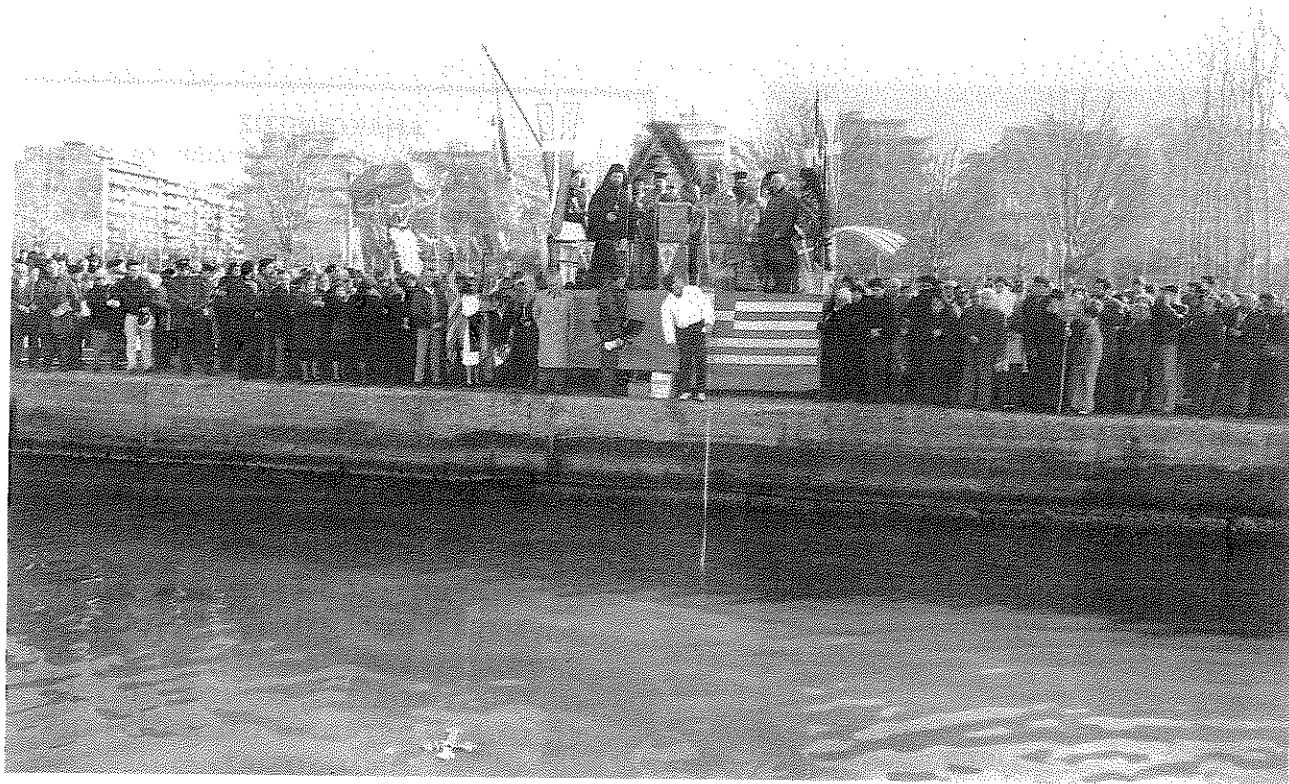
Μερικὴ ἀποψὶς τοῦ λιμενικοῦ χώρου τῆς καταδύσεως.
